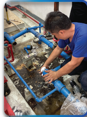
ติดตั้ง Modulating Float Valve
